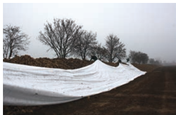
włóknina (szer. 4,9 m) rozkładana na długość z każdej strony pryzmy
